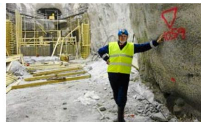
Tord Ekelöf, projektledare, är här 1059 meter under marken i Garpenbergsgruvan.
